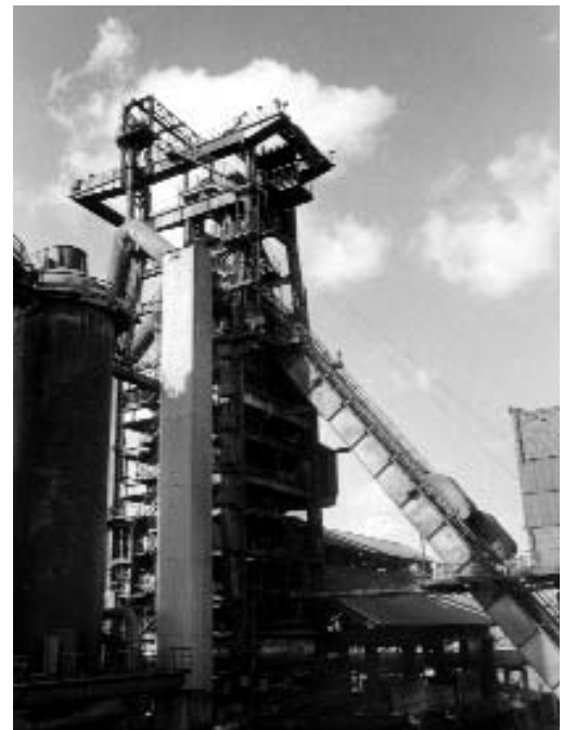
Perspectiva do Alto-Forno e da rampa onde se deslocam os skips que transportam as matérias-primas a introduzir na parte superior do Alto-Forno
