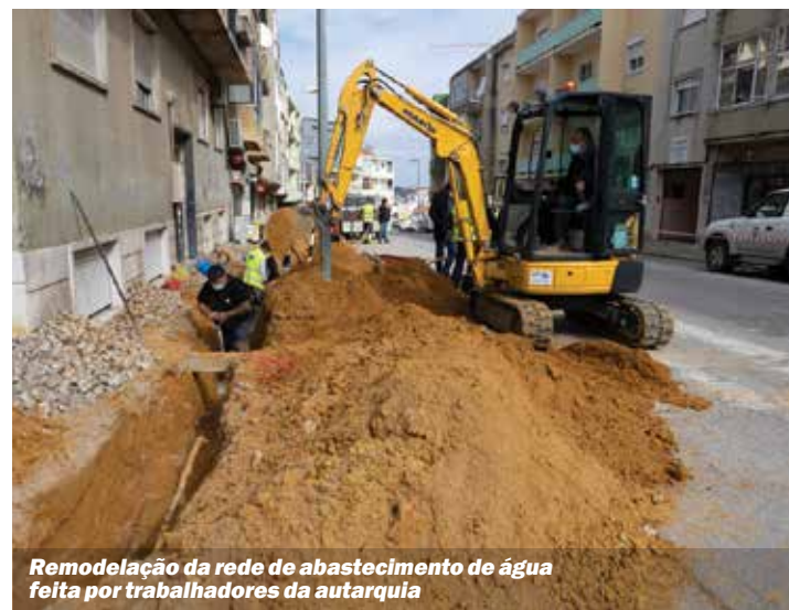
O executivo municipal acompanhou o desenvolvimento das obras na Rua General Humberto Delgado, no Fogueteiro
