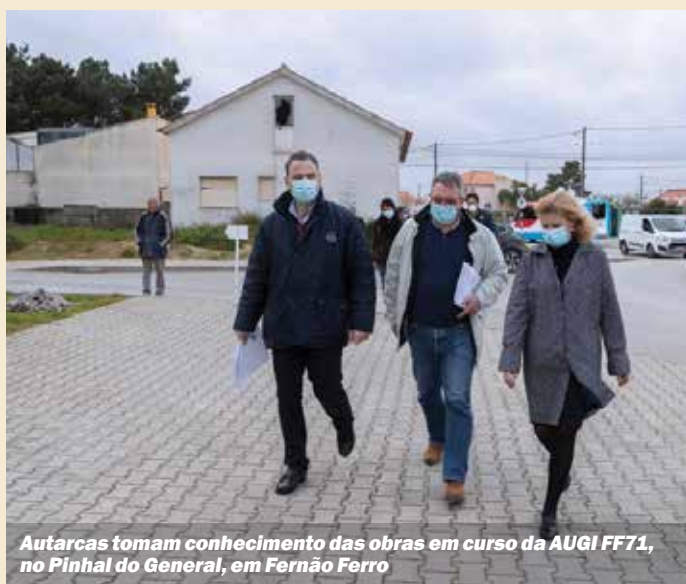
Construção da rede de águas residuais e pluviais na Rua da Juventude, em Fernão Ferro
