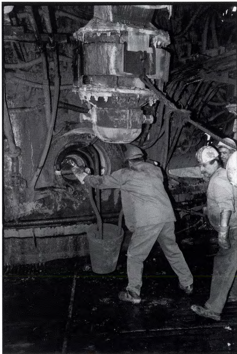
40. Trabalhadores preparando-se para realizar a montagem de uma nova tubeira
