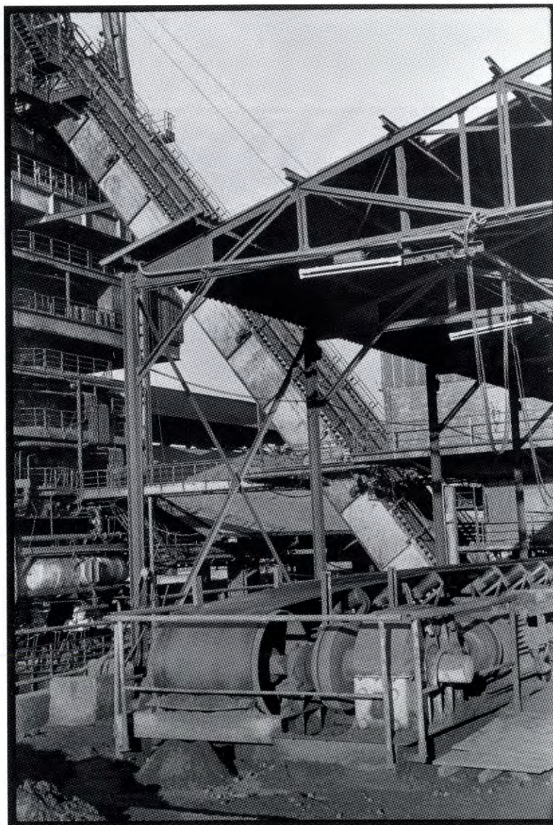
11) Tela transportadora H1 do Parque de matérias-primas que abastece os silos do Alto Forno com coque, minérios de ferro e fundentes. Em segundo plano, o Alto Forno e a rampa dos skips
