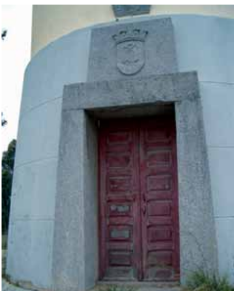
Depósito elevado de água de Corroios © EMS/CDI – Fátima Afonso, 2004.
