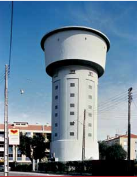
Depósito elevado de água de Cruz de Pau
