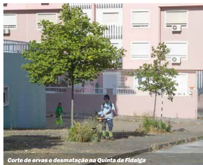
Intervenção na Rua Vereador João Roque, Arrentela
