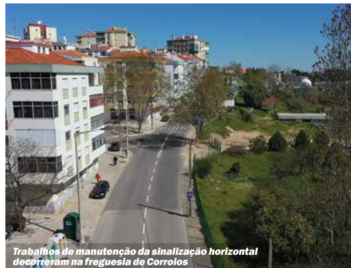
Pavimentação na Rua 1.º de Maio, em Amora
