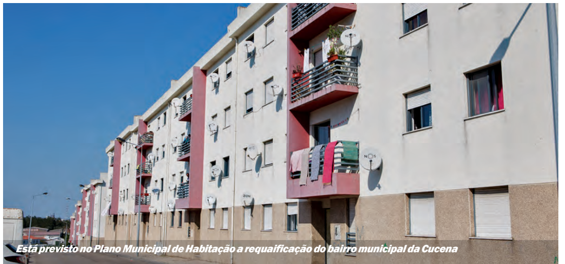
Programa de arrendamento acessível
