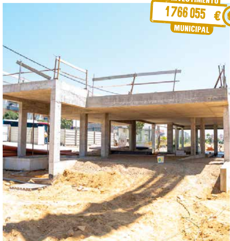
Requalificação e ampliação da Escola Básica de Arrentela
