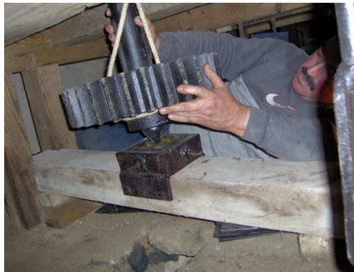
Montagem de engenhos no âmbito de ações de conservação e observação e registo de dados junto das estruturas do Moinho de Maré de Corroios (2009 e 2010).
